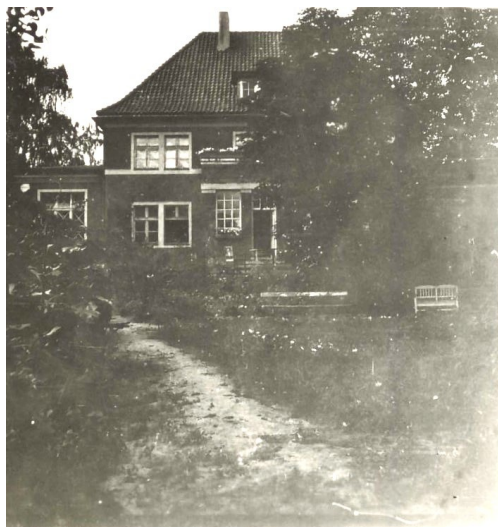
Il. 4. Budynek przy ulicy Pionierów 3. Zbiory PSM
