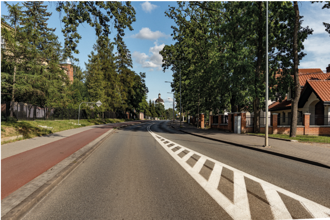
← Widok na wieżę cisnień z okolic skrzyżowania ulic 11 Listopada i Juliana Tuwima. Po lewej Zespół Szkół nr 1 w Ełku. Rok 2025. Fot. Robert Tyska. A view of the water tower from the vicinity of the intersection of 11 Listopada and Juliana Tuwima Streets. On the left is the School Complex no. 1 in Ełk. 2025. Photo by Robert Tyska.
