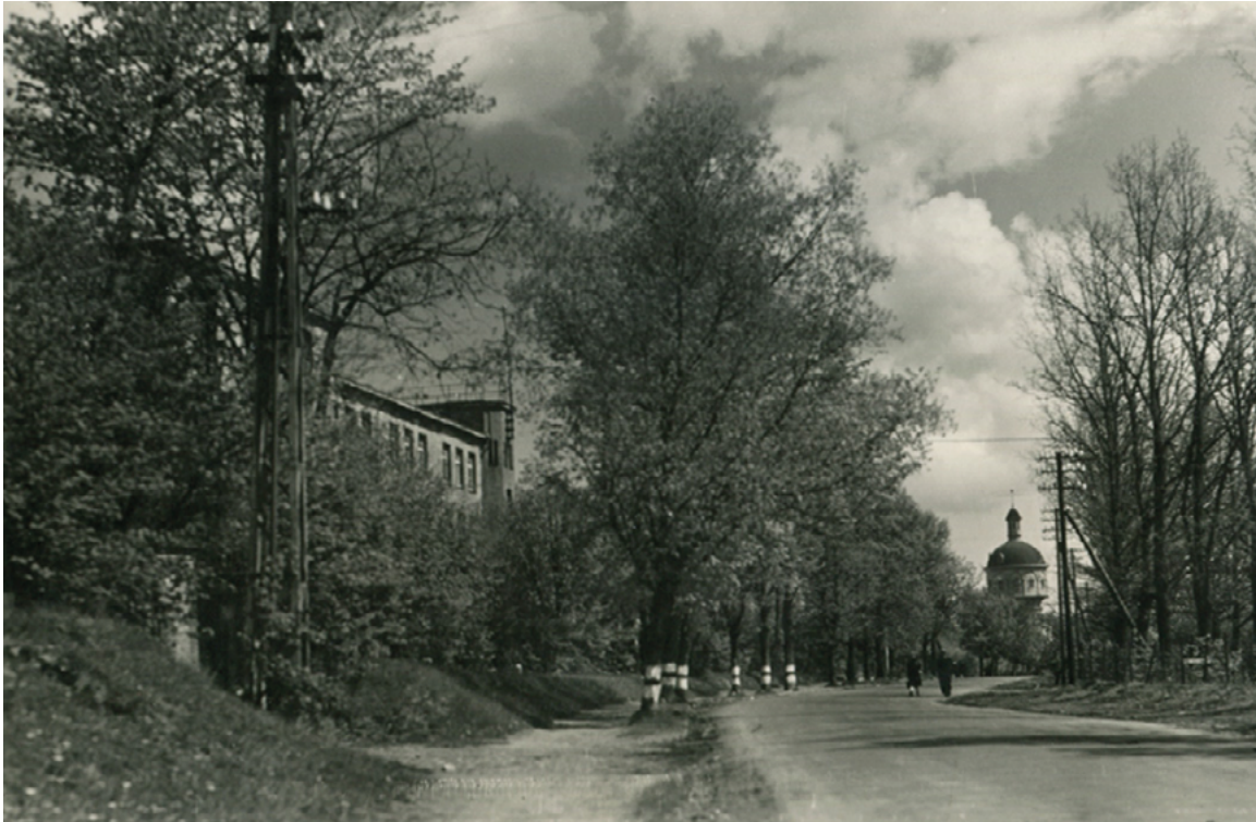
← Widok na wieżę ciśnień z okolic skrzyżowania Wandy Wasilewskiej (ob. 11 Listopada) i Juliana Tuwima. Po lewej Zespół Szkół nr 1 w Ełku. Rok 1957. Kolekcja Giseli i Klausa Skibowskich. Zbiory MHE. A view of the water tower from the vicinity of the intersection of Wandy Wasilewskiej (now 11 Listopada) and Juliana Tuwima Streets. On the left is the School Complex no. 1 in Ełk. 1957. Gisela and Klaus Skibowski's collection. Collections of the MHE.
