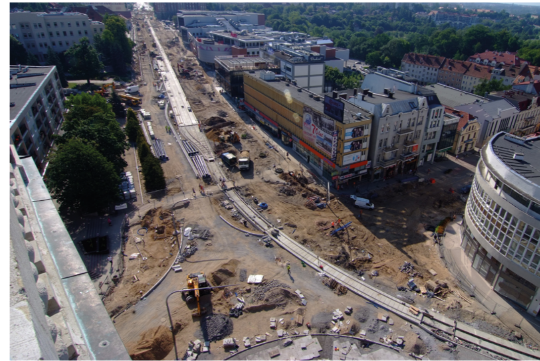
← Budowa reaktywowanej w 2015 r. linii tramwajowej na odcinku ulic Piłsudskiego i 11 Listopada. W głębi widzimy m.in. sylwetkę Centrum Handlowego „Aura” oddanego w 2005 r. na miejscu dawnej ulicy Fabrycznej. Fot. Ryszard Gruskiewicz Construction of the tram line reactivated in 2015 in the section of Piłsudskiego and 11 Listopada Streets. In the background, we can see, among other things, the shape of the Aura Shopping Centre, completed in 2005 on the site of the defunct Fabryczna Street. Photo by Ryszard Gruskiewicz
